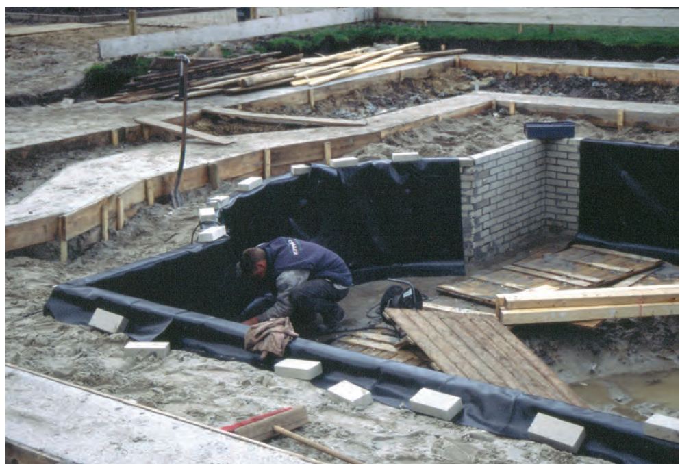
Een kalkzandsteenmuur als 'binnenmuur' van een gemetselde vijver
